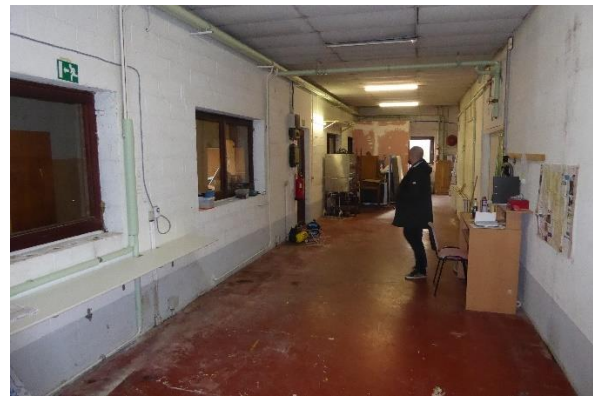
Pièce intermédiaire en forme de couloir située entre la pièce de l'épicerie sociale et le garage servant de lieu de stockage
