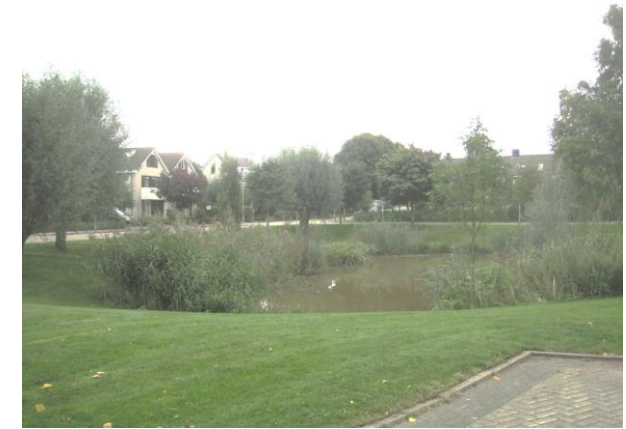
Bassins d'orage aménager (Pays-Bas - Hoevelaken)
